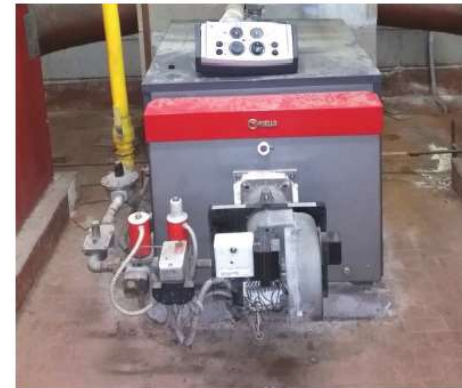
Caldaia Standard per ACS
